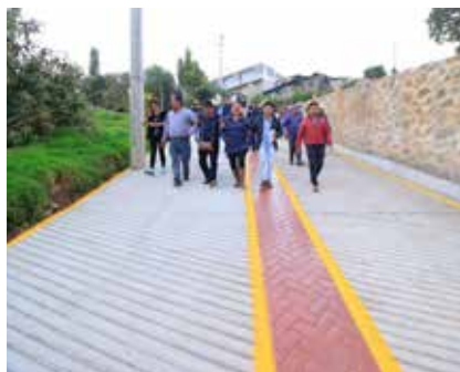
Concreto hidráulico en calle El Pedregal cuarta zona tramo de calle El Mirador, San Mateo Capulhuac.
