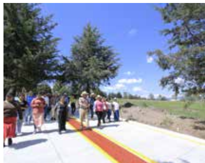
Concreto hidráulico en calle Cuauhtémoc, Santa Ana Mayorazgo.
