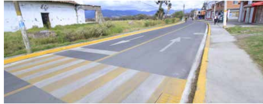
Mezcla asfáltica y rehabilitación de red de agua potable en avenida insurgentes, Barrio El Capulín.
