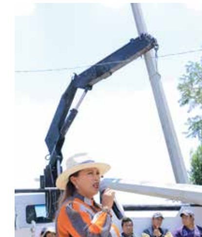
Ampliación de Electrificación en calle El Cerrito, San Mateo Capulhuac.
