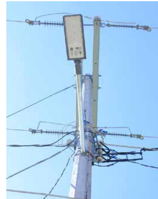
Ampliación de Electrificación en calle Benito Juárez, Barrio Puente San Pedro.
