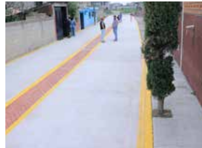
Drenaje Sanitario y concreto hidráulico en calle Girasoles, Ejido de la Y.
