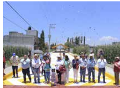
Concreto hidráulico en calle Emiliano Zapata, Santa María Tetitla.
