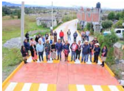
Concreto hidráulico en calle Cortinado, Ejido de Capulhuac.
