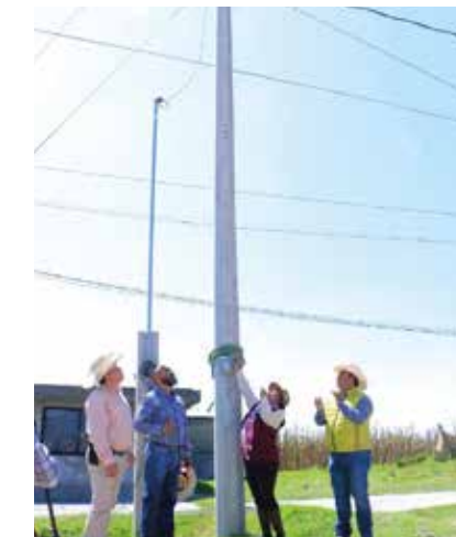
Mantenimiento de Electrificación en calle Benito Juárez, Barrio Puente San Pedro.
