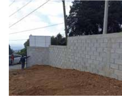
Construcción de Barda perimetral en depósitos de agua potable, Barrio la presa.
