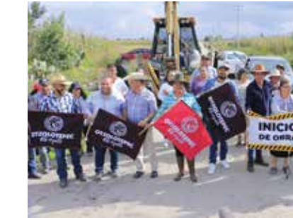
Ampliación de Drenaje Sanitario y Ampliación de red de agua potable en calle Gladiolas, Ejido de la Y.
