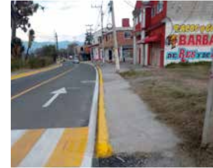
Construcción de pavimentación con mezcla asfáltica y rehabilitación de red de agua potable en av. Insurgentes, Barrio El Capulín.
