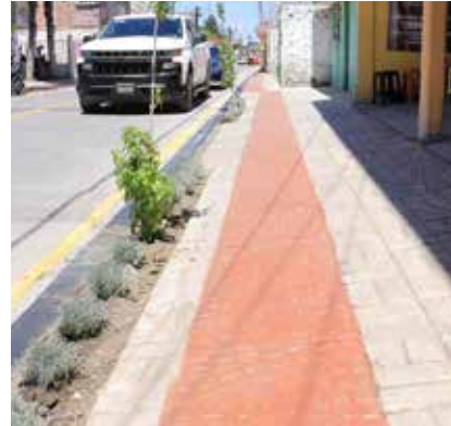
Guarniciones y Banquetas en calle Nicolás Bravo tramo de calle Benito Juárez a calle Francisco I. Madero, Villa Cuauhtémoc.
