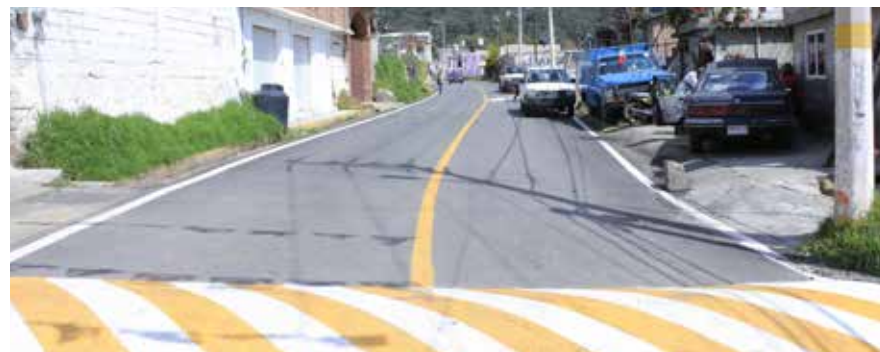
Mezcla asfáltica en calle Cristóbal Colon, Barrio La Huánica.
