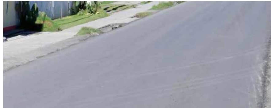
Rehabilitación de mezcla asfáltica en avenida Toluca tramo del parque Toluca 2000 de sur a norte.
