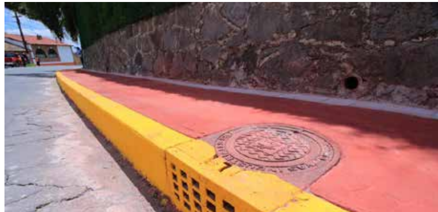
Guarniciones, Banquetas y drenaje pluvial en calle Cedros tramo frente a casa de salud, San Agustín Mimbres.
