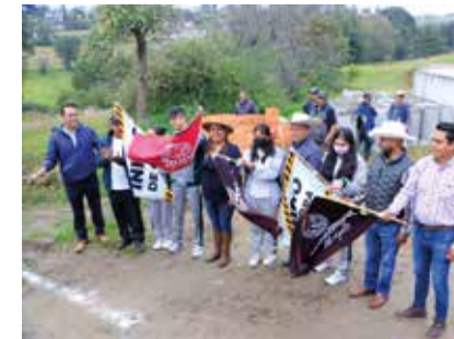
construcción de drenaje sanitario en zona de El Toril, San Agustín Mimbres.
