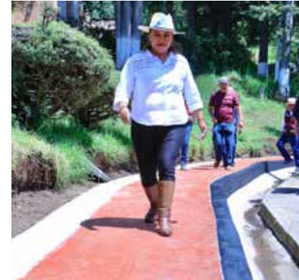
Guarniciones y Banquetas camino a Capulhuac tramo de Fábrica María, Fábrica María.
