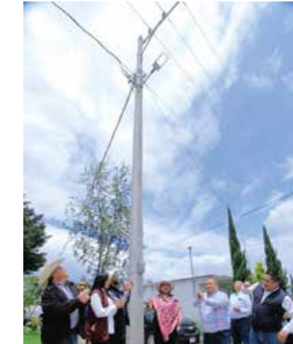
Electrificación en calle Nueva Aurora, La Concepción de Hidalgo.
