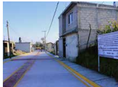
Concreto hidráulico y rehabilitación en calle independencia tramo de avenida México, Ejido de Mozoquilpan.
