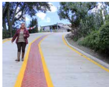
Concreto hidráulico en calle El Pocito Primera Zona Tramo de calle Benito Juárez, San Mateo Capulhuac.
