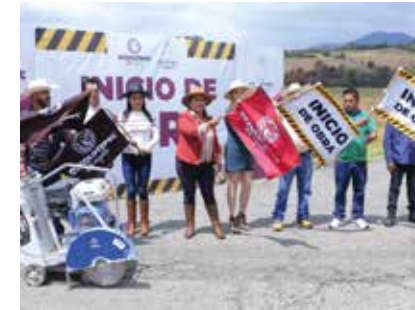
Inicio de construcción de drenaje sanitario en calle insurgentes, Barrio La Rosa.
