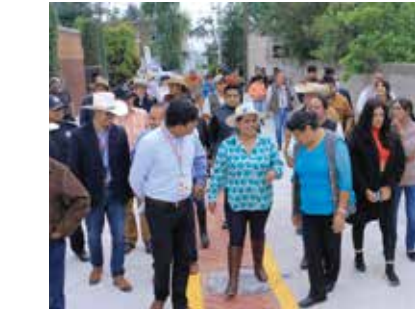
construcción de Drenaje Sanitario y Construcción de pavimentación con concreto Hidráulico en calle Girasoles, Colonia Guadalupe Victoria.
