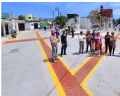
Concreto hidráulico en calle 5 de mayo interconexión con calle Ignacio Zaragoza, villa Cuauhtémoc.
