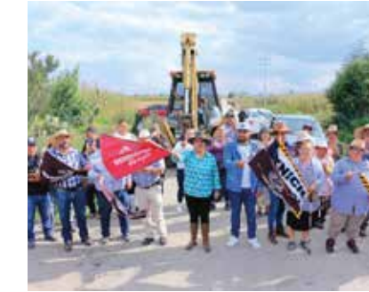
Ampliación de red de agua potable en calle Gladiolas, Ejido de la Y.
